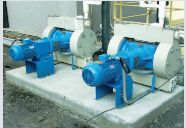
EM-050-PP para transportar aguas residuales ácidas en la industria química
