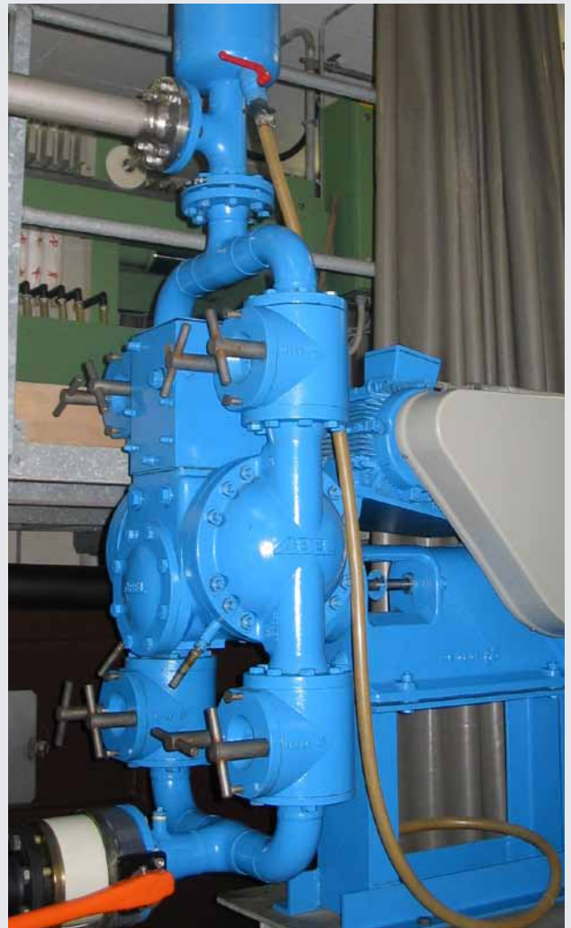
Kugelveile mit Revisionsöffnungen und Membranleckageanzeige
