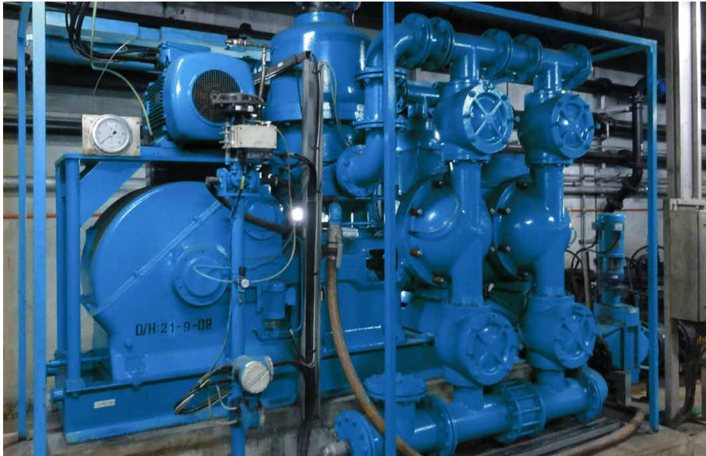
ABEL-Kolbenmembranpumpe der CM-Baureihe für Rohabwassertransport auf einer Großkläranlage in Asien
