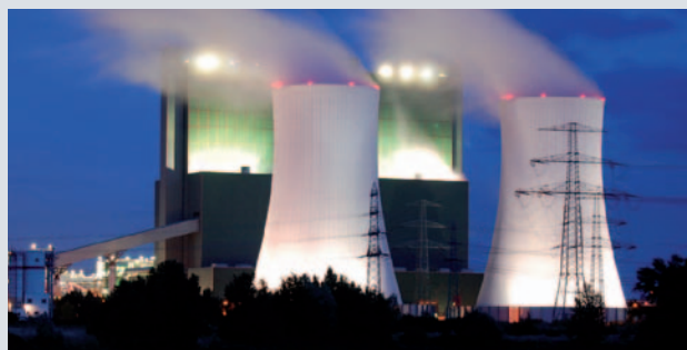
Centrales eléctricas, desulfuración de los gases de combustión.
