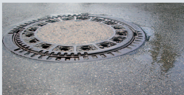
Operaciones de tratamiento de aguas residuales y estaciones de bombeo
