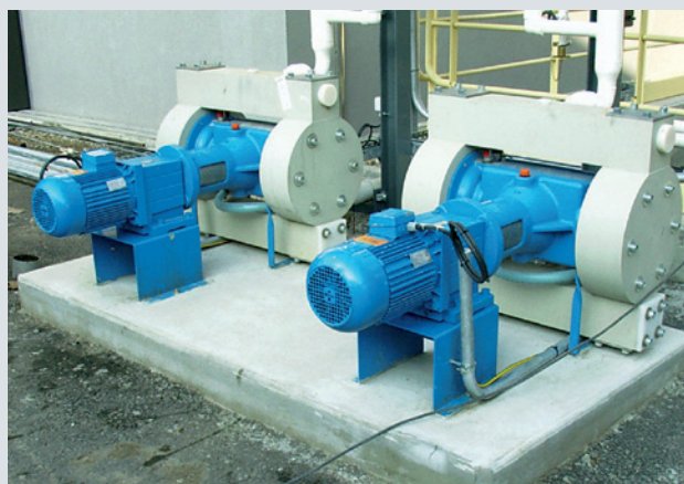
EM-050-PP pour le pompage d'eaux chargées acides dans l'industrie chimique
