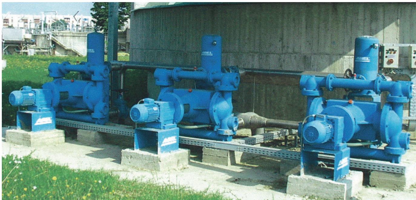
Utilisation de la pompe ABEL EM dans une station d'épuration communale - souvent l'alternative la plus rentable pour le pompage de boues contenant des matières fibreuses
