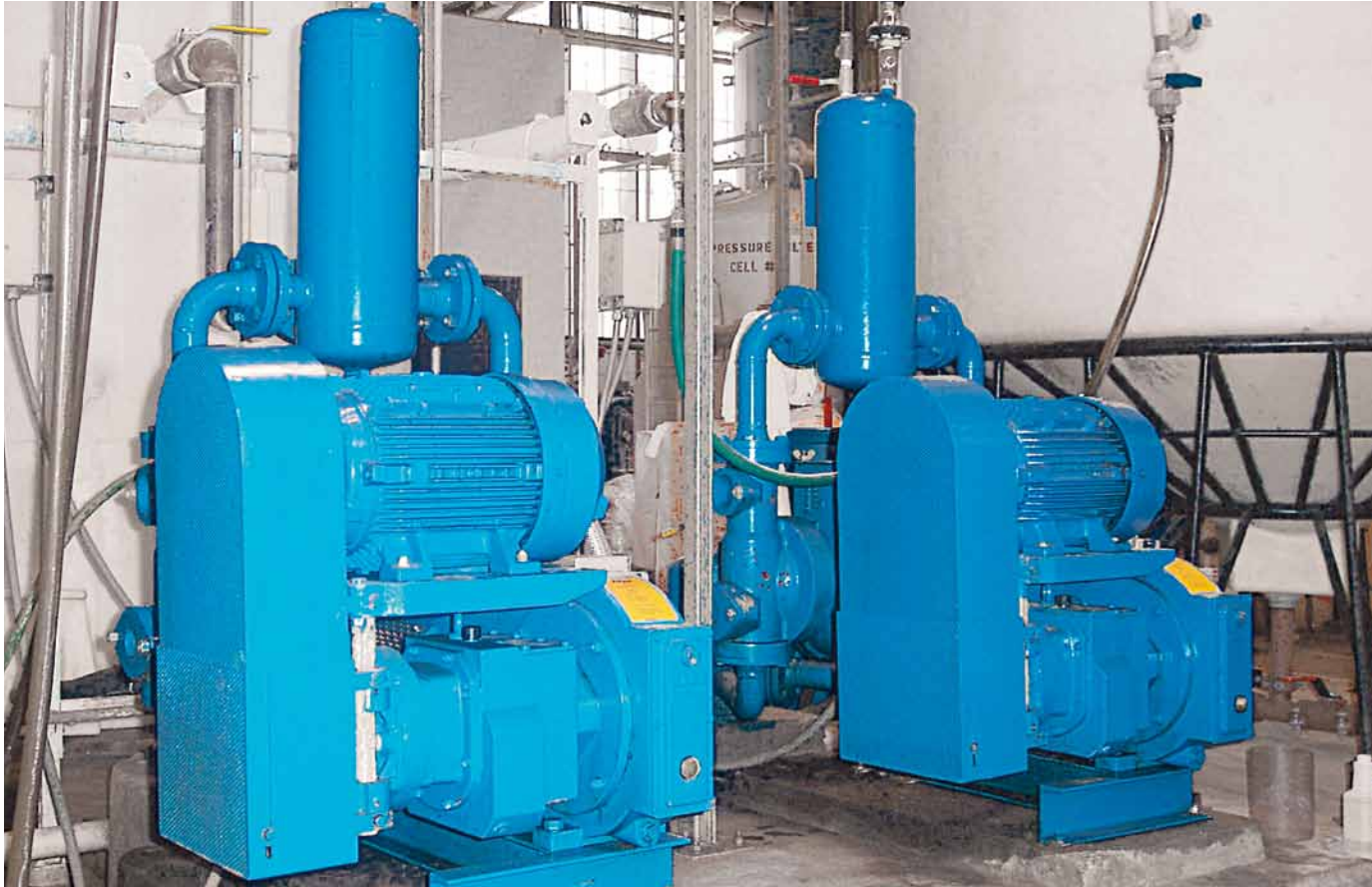
ABEL HMD-G-12-0060 zur Förderung kontaminierter Schlämme aus der Bodenwäsche
