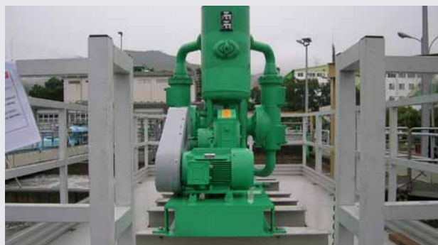
ABEL-HM zur Förderung von Schwimmschlamm
