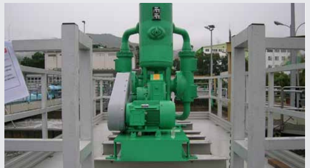
ABEL-HM zur Förderung von Schwimmschlamm
