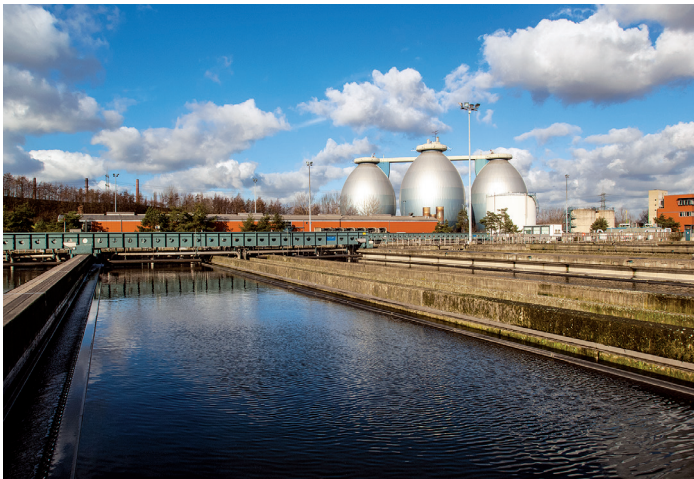
Abb. 1: Die Zentrale Schlammbehandlungsanlage der EMSCHERGENOSSENSCHAFT in Bottrop (Quelle: Emschergenossenschaft Essen)
